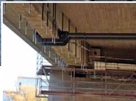
Noch sind die blanken Stangen unterhalb des Bauwerks zu sehen. Als nächster Schritt sollen diese mit Traversen verbunden werden.
