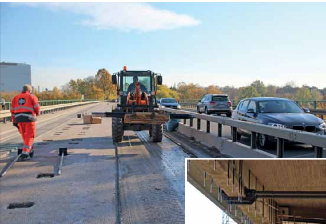
Insgesamt 242 Stangen werden montiert, um die Schubverstärkung herzustellen.
